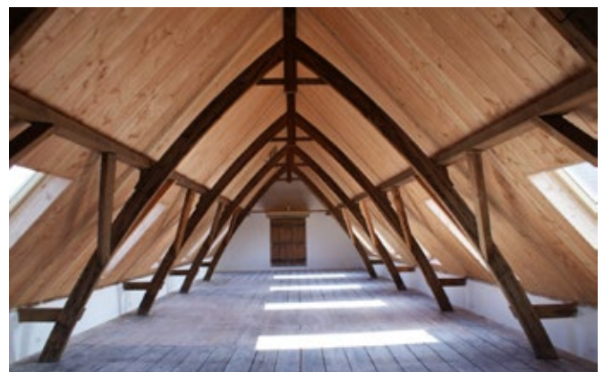
Beschermde Philibertspanten, ook schenkelspanten genoemd, worden gekenmerkt door gebogen benen
