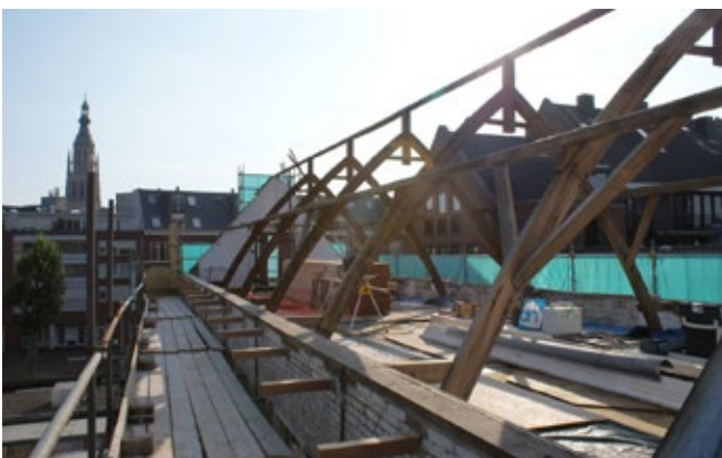
Beschermde Philibertspanten, ook schenkelspanten genoemd, worden gekenmerkt door gebogen benen
