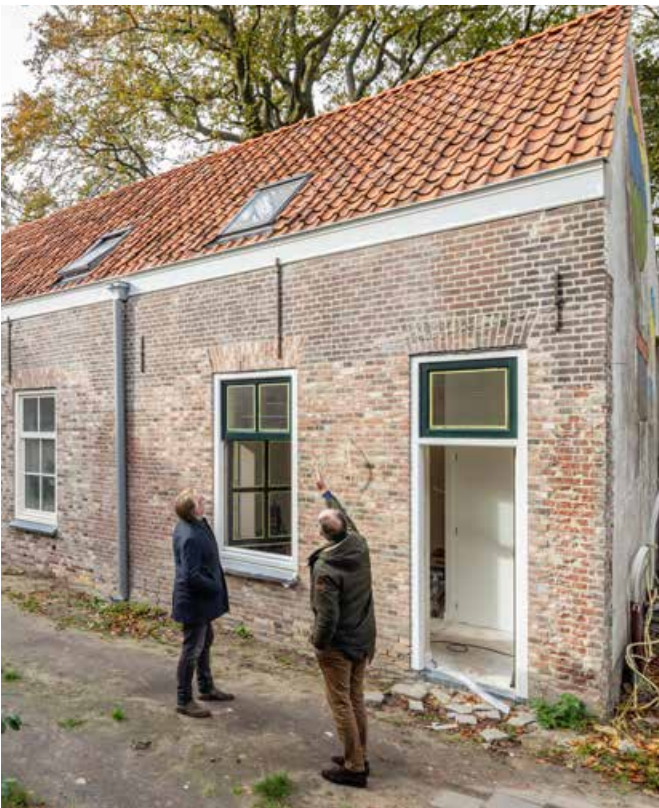
Werkbezoek Remco Vos van het Nationaal Restauratiefonds Foto: BASEPHOTOGRAPHY iov Restauratiefonds
