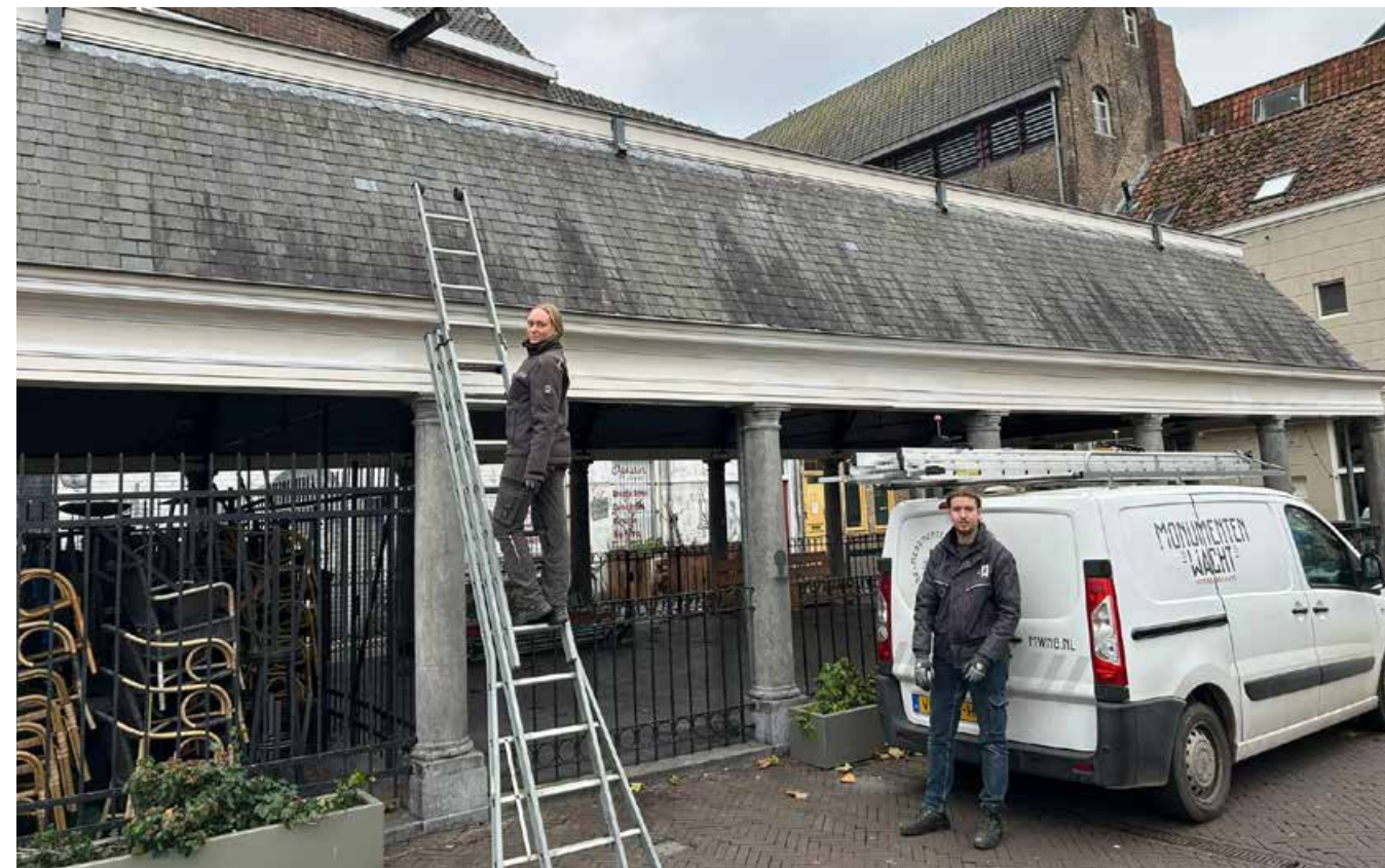
Monumentenwacht aan het werk bij het Klapcot en de Vishal
