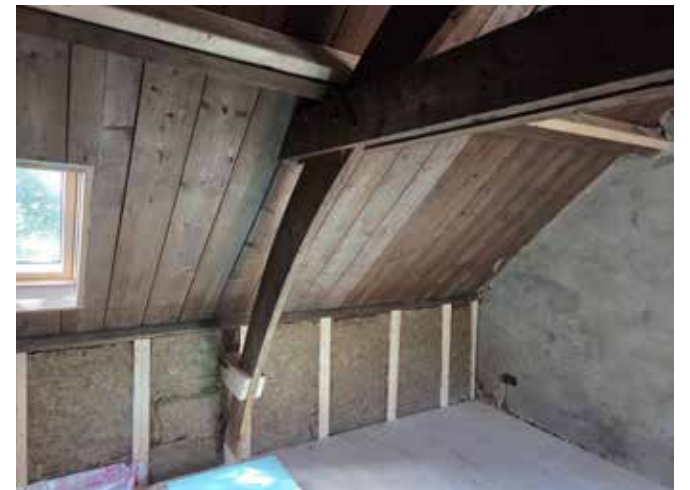
Philibert-spanten na restauratie
